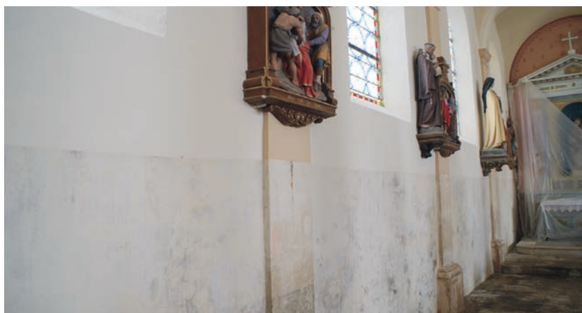
▲ Het bovenste deel van de muur is geschilderd met silicaatverf, het onderste deel is onbehandeld gehouden voor de toepassing van elektro osmose.
