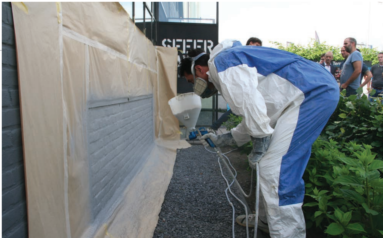
◀ Kerstens geeft een spuitdemonstratie: "De coating kan probleemloos over oude verflagen heen worden aangebracht."
