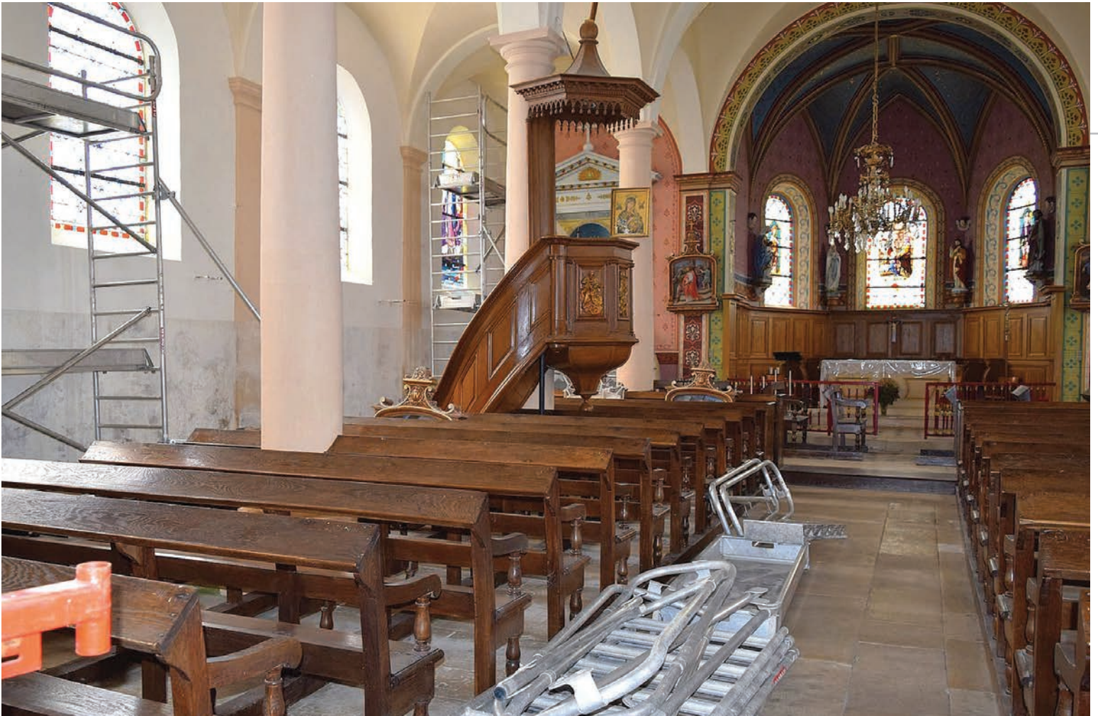
▲ Interieur van de kerk in Bovée sur Barboure. Links is goed te zien dat nu alleen het bovenste gedeelte van de muren is geschilderd, zodat de elektrotechnici van StopRise hun werk kunnen doen om de vochtproblemen aan te pakken.
