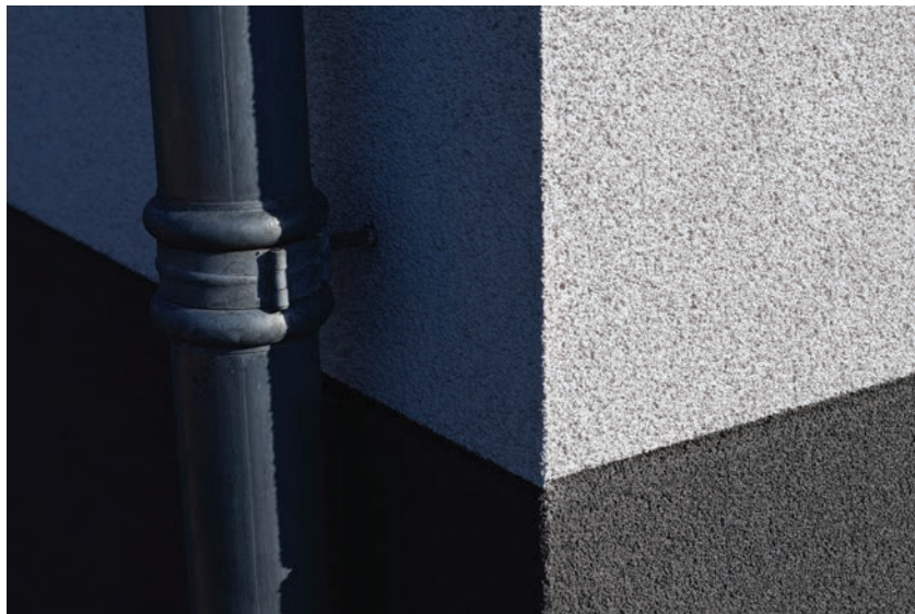
▲ Spuitkurk is in verschillende korreldiktes aan te brengen. De standaardkorrel is voor op gevels en daken bedoeld.
