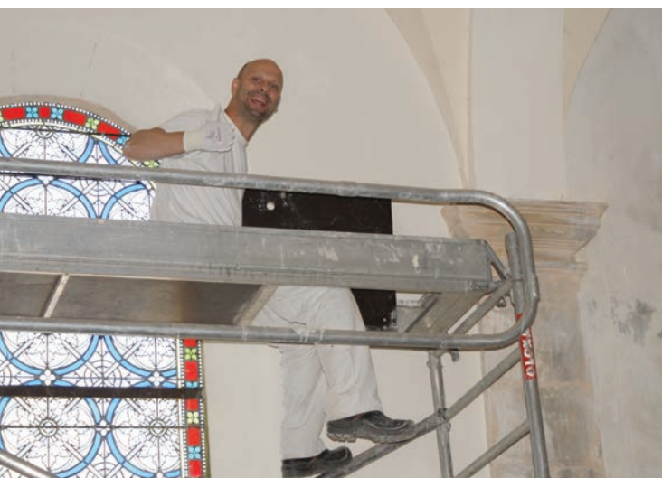
▲ Het bovenste deel van de muur is geschilderd met silicaatverf, het onderste deel is onbehandeld gehouden voor de toepassing van elektro osmose.
