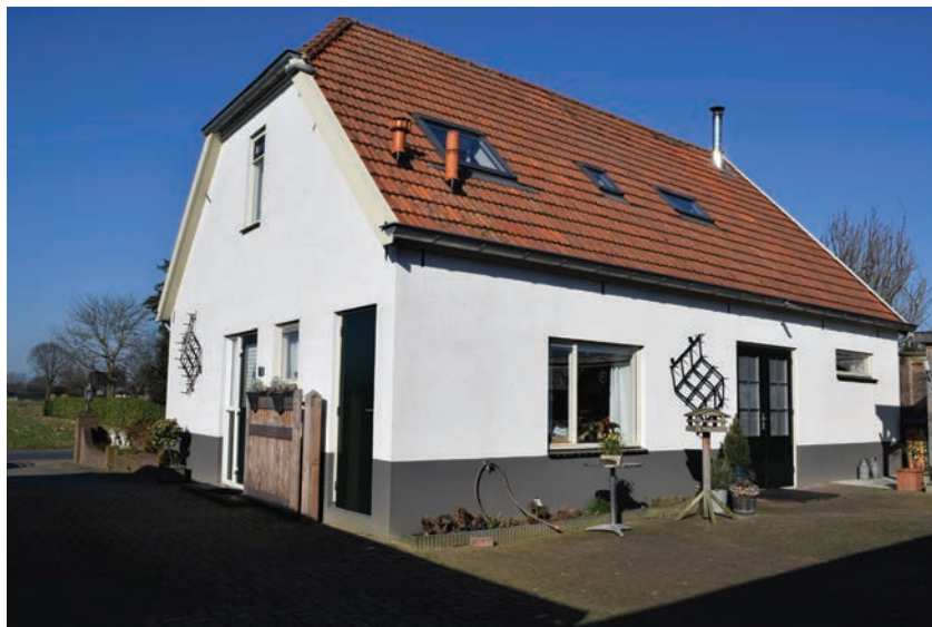
▲ Een met spuitkurk afgewerkte woning in Nieuw-Wehl.
