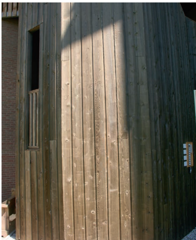
▲ Op sommige geveldelen werden oude lagen kookverf er, onder hogedruk, met water secuur vanaf gespoten. Eindresultaat was super schoon hout, dat weer prima kon worden geschilderd.
