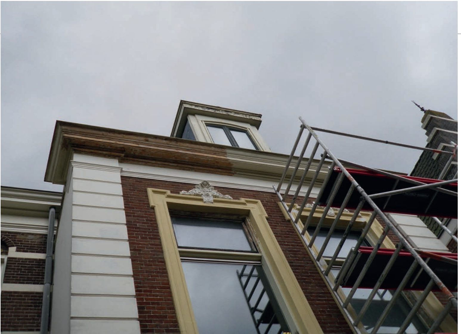
▲ Wanneer oude verflagen moeten worden verwijderd, is het oppassen geblazen. Bij schuren, schrappen of afbranden kunnen zware metalen vrijkomen.
