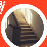
Vaste trap plaatsen
